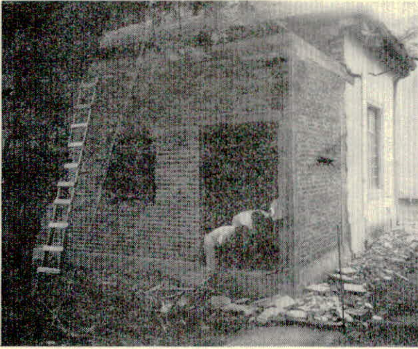
Reconstrucción del ex-edificio de la Radio.
