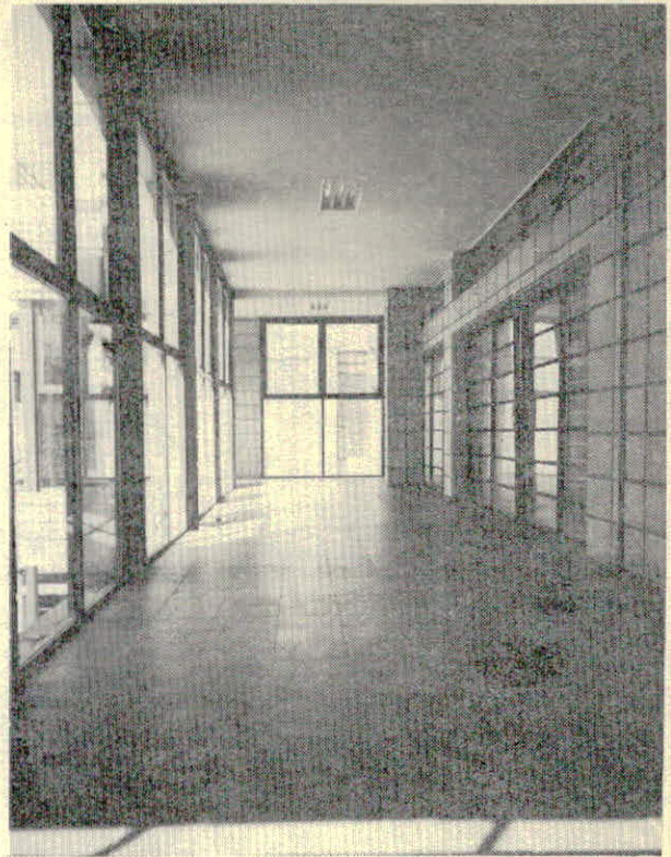
Colocación de cerámicos y vidrios en Físico-matemáticas.
